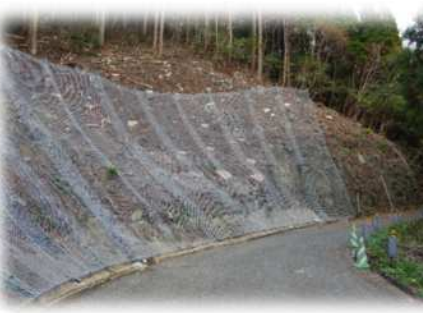
ロックネット工
