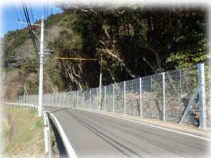
落石防護柵工
