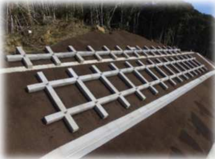
法枠工 植生基材吹付工
