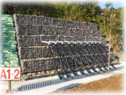
地下水排除工
